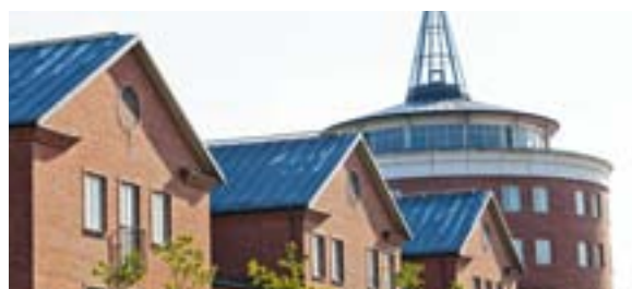
Torsvik 5, Härnösand, 8 600 kvm. Belägen i centrala Härnösand invid E4an. Exempel på hyresgäster är Trafikverket, Sweco och kommunförbundet Västernorrland.
